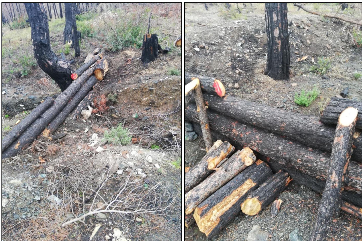
Εικόνα 3.2.2.29. Κορμοφράγματα για αντιδιαβρωτική προστασία στην πληγείσα περιοχή.
