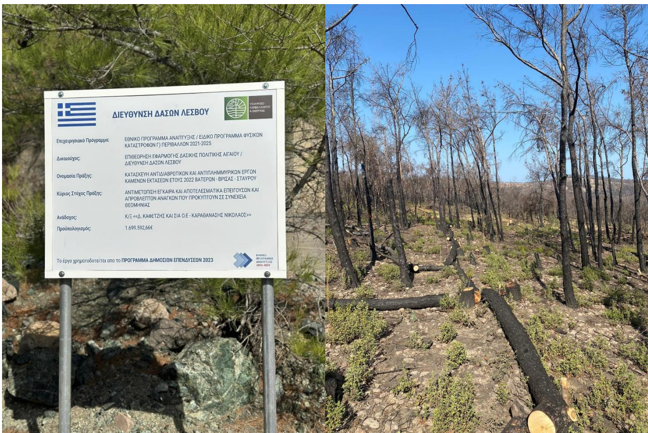
Εικόνα 4.9. Κατασκευή αντιδιαβρωτικών και αντιπλημμυρικών έργων στις καμένες εκτάσεις από τη Διεύθυνση Δασών Λέσβου, με προϋπολογισμό περίπου 1.700.000 €.
