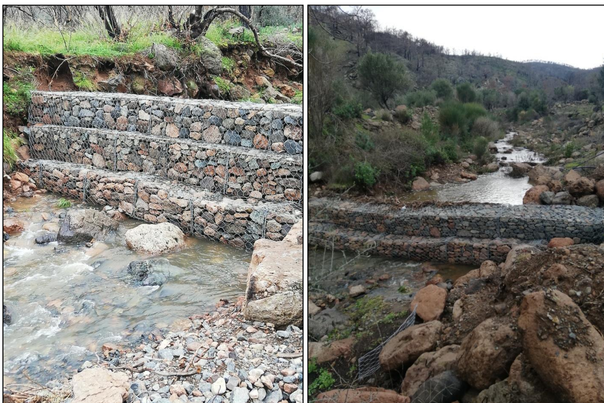
Εικόνα 3.2.2.30. Συρματοπλεκτα κιβώτια ως φράγματα ανάσχεσης της ταχύτητας ροής στην πληγείσα περιοχή.
